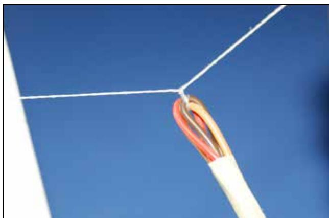
13) Attacher la cordelette déjà passée dans le stab. à la rallonge côté sans prise.
