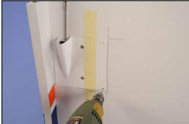
Puis percer les 4 trous pour sa fixation dans le stab.
